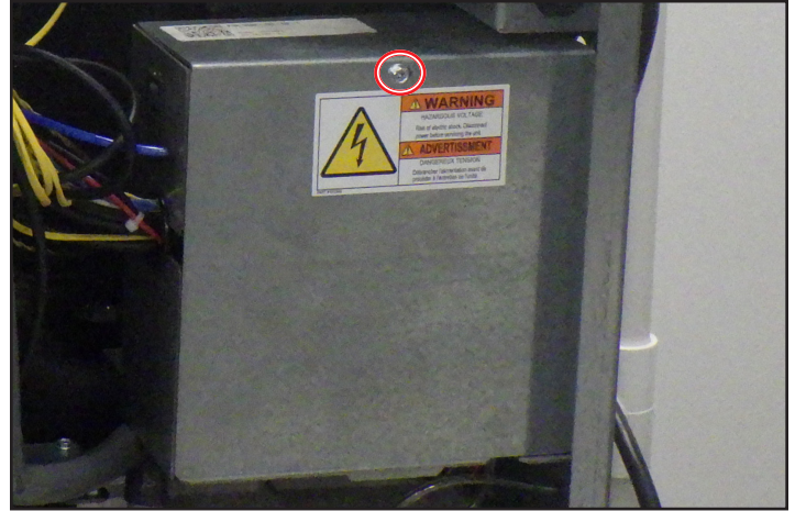
Fig. 1. Ubicación del tornillo de la tapa de la caja eléctrica.
