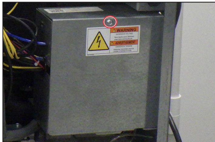
Rys. 1. Lokalizacja wkrętów pokrywy skrzynki elektrycznej.
