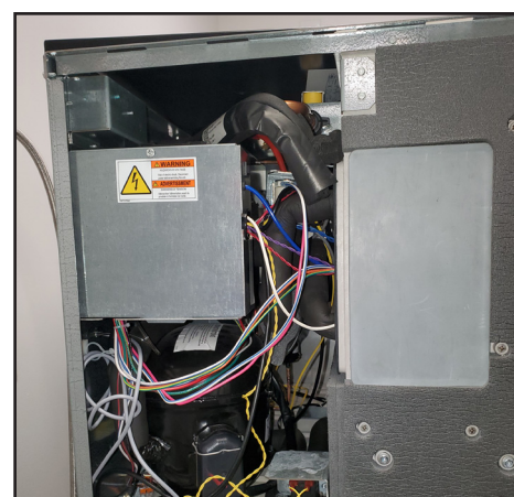
Rys. 2. Zdjąć panel górny i prawy panel boczny.
