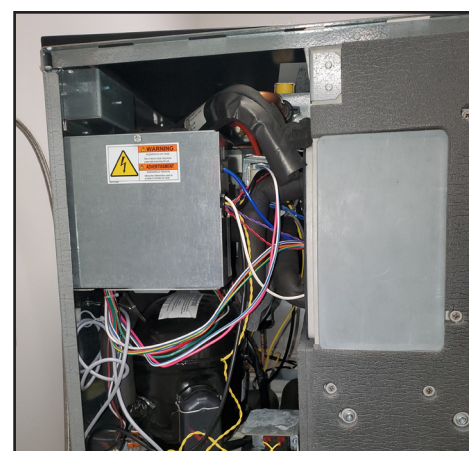
Afb. 2. Verwijder het bovenpaneel en het linker zijpaneel.
