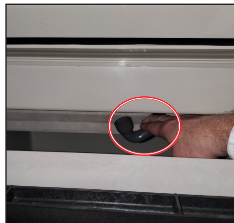
Fig. 4. Ricollegare il tubo di scarico alla vaschetta di raccolta dell'acqua.
