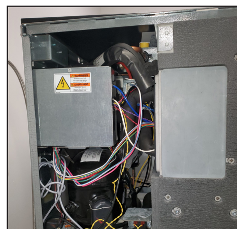
Fig. 2. Togliere il pannello superiore e il pannello a sinistra.
