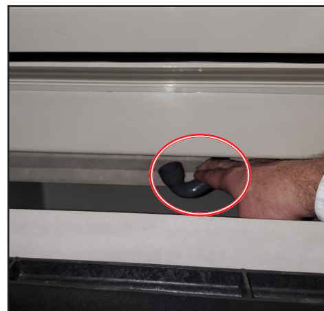
Fig. 4. Reconnectez le tuyau de drainage au puisard d'eau.
