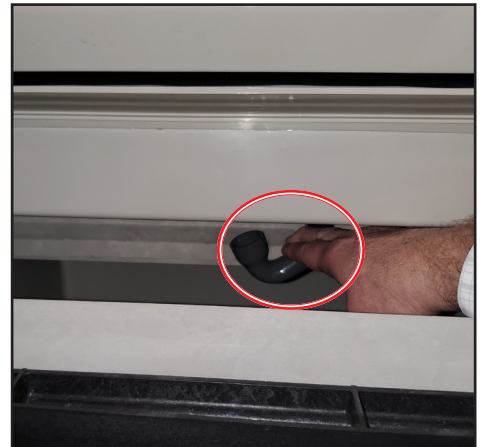
Fig. 4. Vuelva a conectar la manguera de drenaje al colector de agua.
