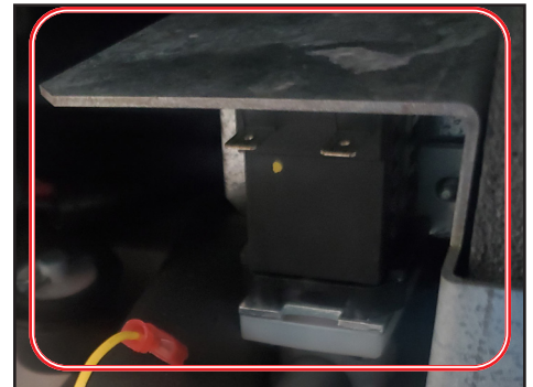
Fig. 2. Fije el conjunto a la ménsula de montaje y conecte el conjunto a la máquina de hielo.
