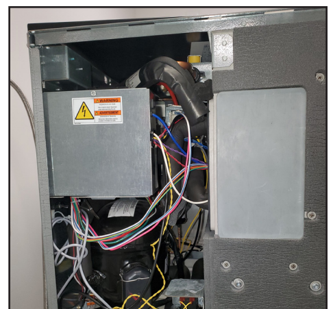
Fig. 2. Retire el panel superior y el panel lateral izquierdo.
