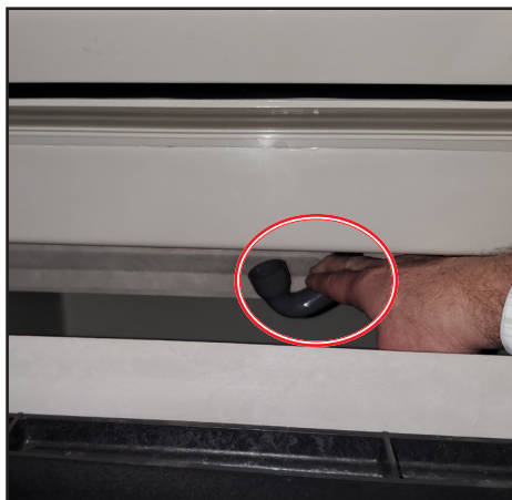
Fig. 1. Desconecte la manguera de drenaje del colector.
