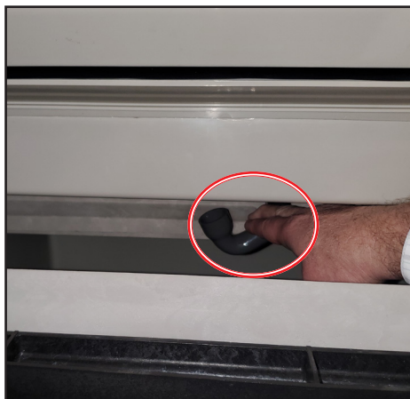
Abb. 1. Entfernen Sie den Ablaufschlauch von der Wanne.
