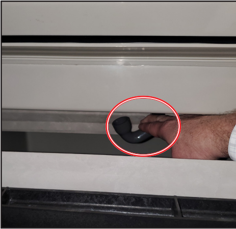
الشكل 4. أعد توصيل خرطوم التصريف بحوض الماء.
