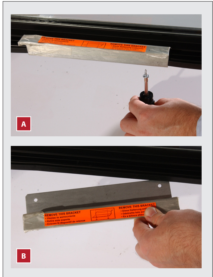
Abb. 2. Die Transportsicherung bei Schwenktüren aus Glas entfernen, sofern vorhanden. Die Sicherungen NICHT entsorgen.
