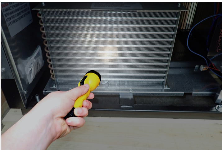
Fig. 3. Utilice una linterna para realizar la inspección y confirmar que el serpentín está limpio.
