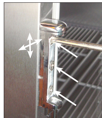
Rys. 4. Położenie wkrętów zawiasu drzwi. Odpowiednio przesunąć zawias.
