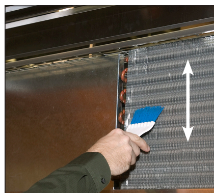
Afb. 3. Nooit dwars over de spoelribben vegen.
