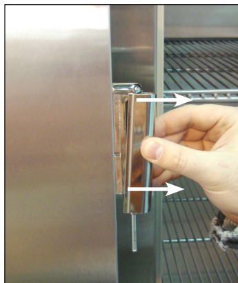
Afb. 3. Trek de scharnierplaat van de deurscharnier.
