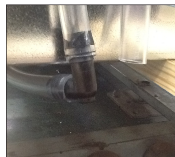
Afb. 6. Sluit de hoekstukken op de slangen van de kast aan.
