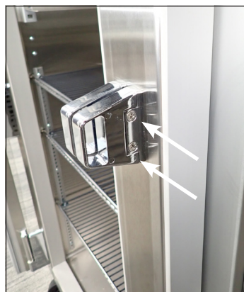
Fig. 5. Posizioni delle viti del fermo.
