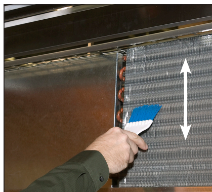
Fig. 3. Non spazzolare mai sulle alette della serpentina di traverso.
