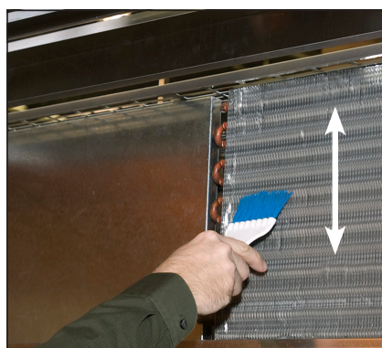
Fig. 3. Ne brossez jamais perpendiculairement aux ailettes du serpentin.
