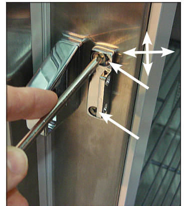
Fig. 6. Ubicación de los tornillos de la base del bloqueo. Mueva la base según sea necesario.
