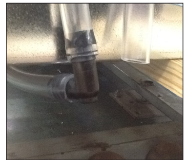
Fig. 6. Conecte el conector arponado a las mangueras del gabinete.
