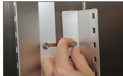
Fig. 3. Instalación de columnas para bandejas universales en el centro de la parte trasera del gabinete.
