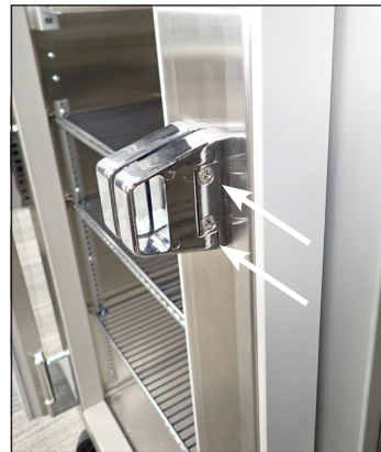
Fig. 5. Ubicación de los tornillos del cerrojo.
