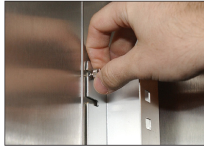
Abb. 1. Einbau der Pfeiler an der Seitenwand des Schrankes.
