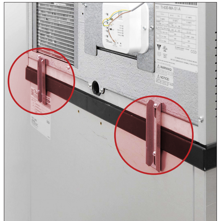
Fig. 8. Ménsulas del depósito instaladas.
