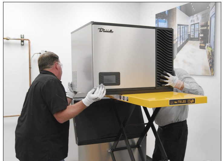
Fig. 4. Mediante ayuda para elevación, coloque con cuidado el modelo TCIM.
