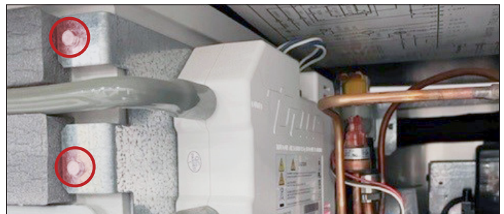
Fig. 2. Vista lateral del sistema de luz ultravioleta de TrueZone. Ubicaciones de los tornillos de la ménsula de TrueZone.
