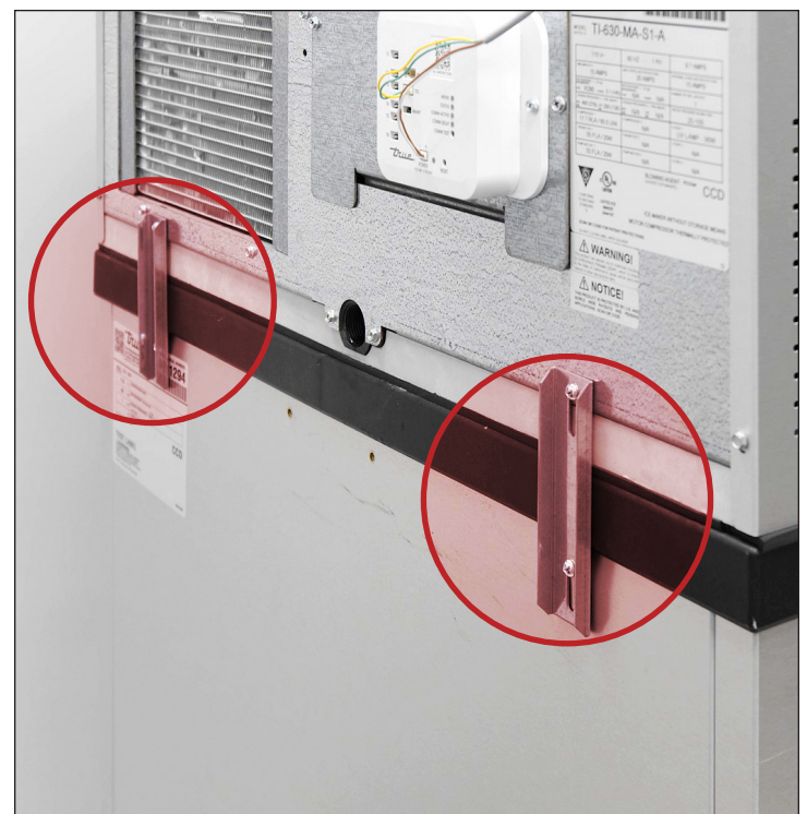
Рис. 8. Смонтированные кронштейны для крепления к контейнеру.
