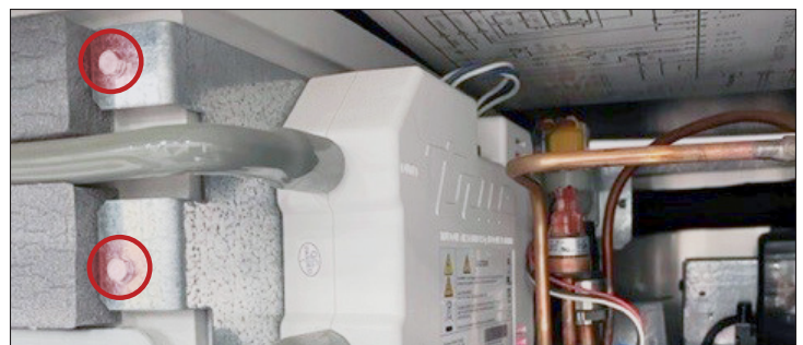
Рис. 2. УФ-система TrueZone, вид сбоку. Места установки винтов для крепления кронштейна система TrueZone.
