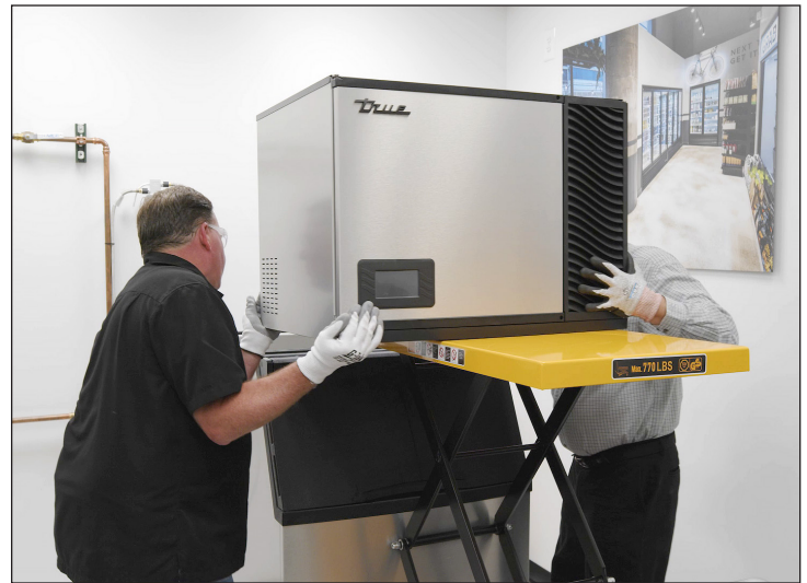
Рис. 4. С помощью подъемника аккуратно установите TCIM на место.
