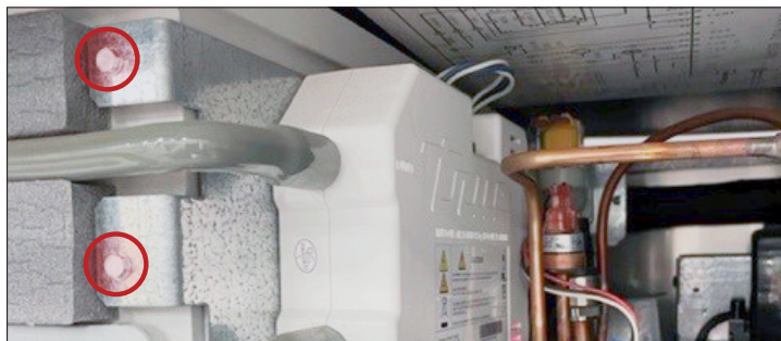
Rys. 2. Widok z boku systemu UV TrueZone. Położenie śrub wspornika TrueZone.
