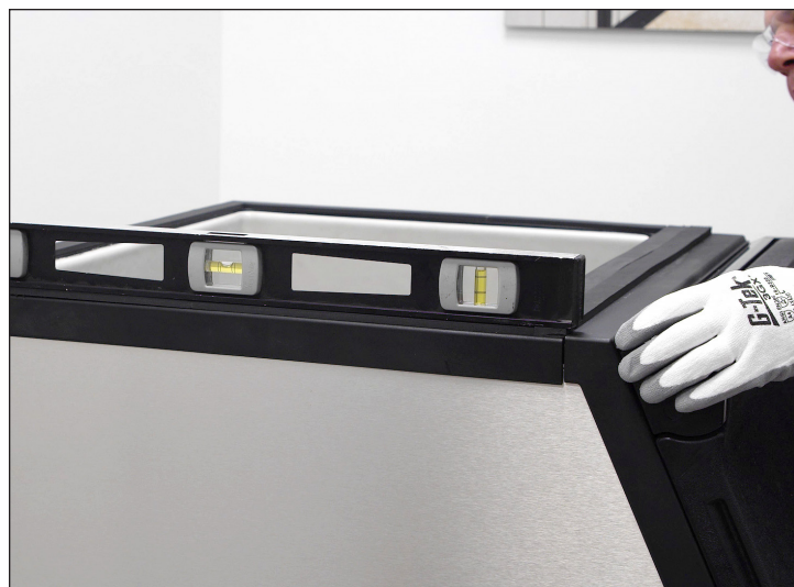
Rys. 3. Przed umieszczeniem kostkarki sprawdzić poziom przechowywanego lodu.
