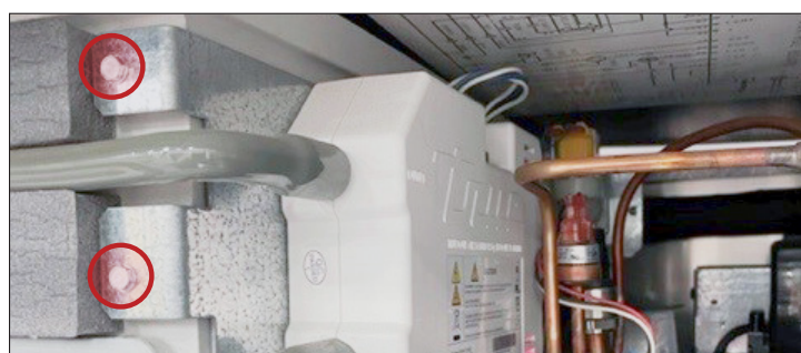
Afb. 2. Zijaanzicht TrueZone uv-systeem. Locaties van schroeven voor TrueZone-houder.
