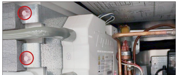
Fig. 2 Vista laterale del Sistema UV TrueZone. Ubicazioni delle viti della staffa TrueZone.
