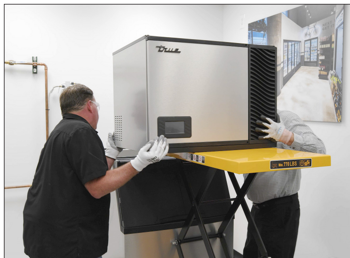
Fig. 4 Con l'ausilio di mezzi di sollevamento, posizionare con cautela il TCIM.
