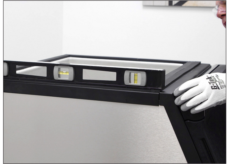
Abb. 3. Prüfen Sie, ob der Eisvorratsbehälter gerade steht, bevor Sie das TCIM aufstellen.
