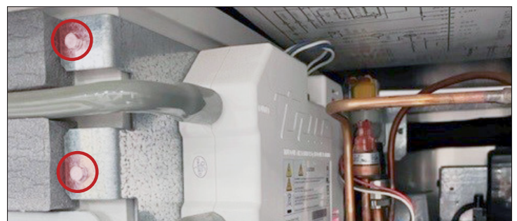
Abb. 2. Seitenansicht des TrueZone UV-Systems. Position der Schrauben der TrueZone-Halterung.
