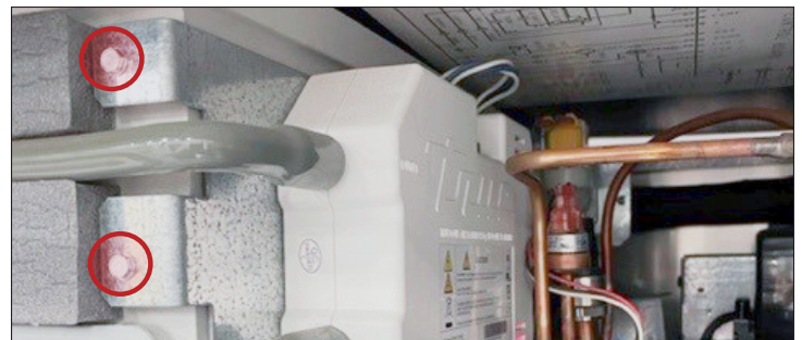
Figure 2. Vue latérale du système UV TrueZone. Emplacements des vis du support TrueZone.
