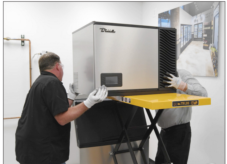
Figure 4. Avec une assistance au levage, positionner soigneusement la machine TCIM.
