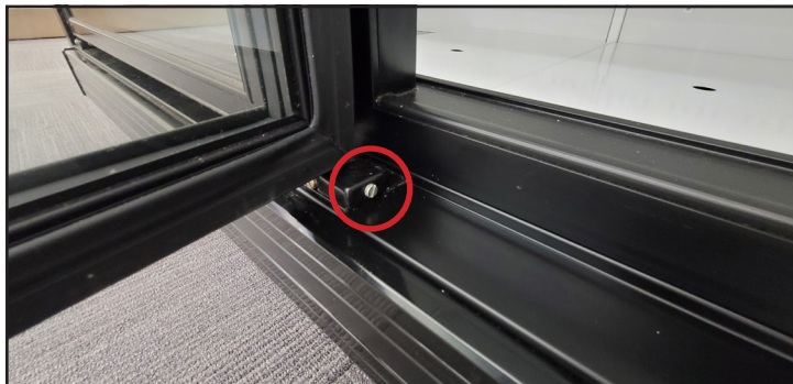
Fig. 3. Emplacement de la vis de réglage de l'alignement de la porte en bas de la porte.
