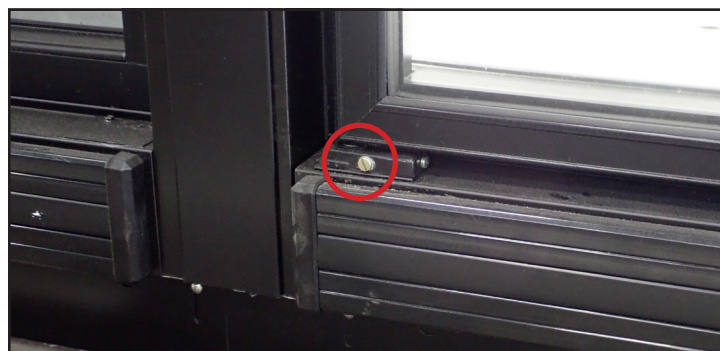
Fig. 4. Emplacement de la vis de réglage de la tension de la porte en bas de la porte.
