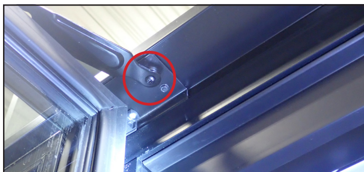
Fig. 15. Emplacement de la vis du support de maintien en position ouverte sur le haut de la porte.
