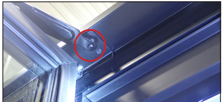
Fig. 15. Ubicación del tornillo del soporte de retención en la parte superior de la puerta.
