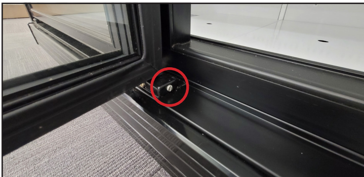
Fig. 3. Ubicación del tornillo de ajuste de alineación de la puerta en la parte inferior de la puerta.
