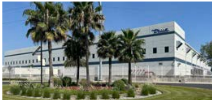
Monterrey, Nuevo León, Mexico
