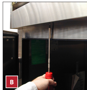
Figure 2. Selon l'accessibilité, nettoyez le serpentin du condenseur. Ne brossez jamais perpendiculairement aux ailettes du serpentin.
