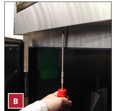
Afb. 2. Reinig de koelbatterij, indien toegankelijk. Nooit dwars over de spoelribben vegen.
