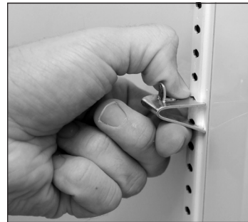
Fig. 3. Es posible que tenga que presionar o girar la parte inferior del elemento de fijación para instalarlo.
