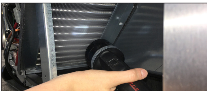
Abb. 4. Prüfen, ob alle Verstopfungen beseitigt wurden.
