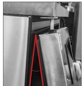
Afb. 10. Gebruik indien nodig een kleine hoek bij het positioneren van de deur.
