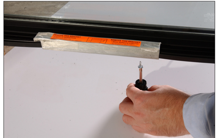
الشكل ٢. تجنب إزالة كتيّفات الشحن حتى توضع الوحدة في موقعها النهائي.
