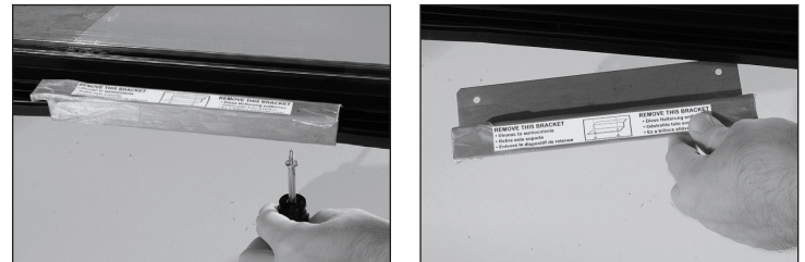
Fig. 2. Retire el soporte de transporte de la puerta de vaivén de cristal, si lo hay. No la deseche.
