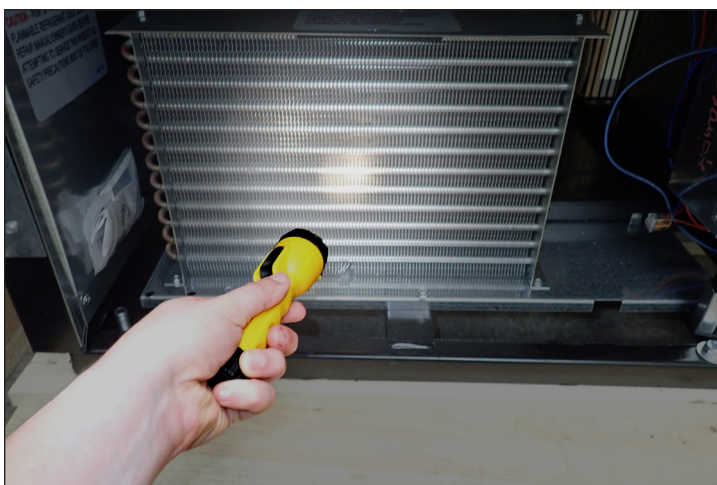
Fig. 3. Utilisez une lampe de poche pour inspecter et confirmer la propreté de la bobine.
