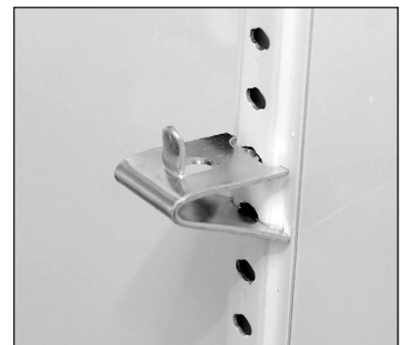
Fig. 4. Gancho para estantes instalado.
