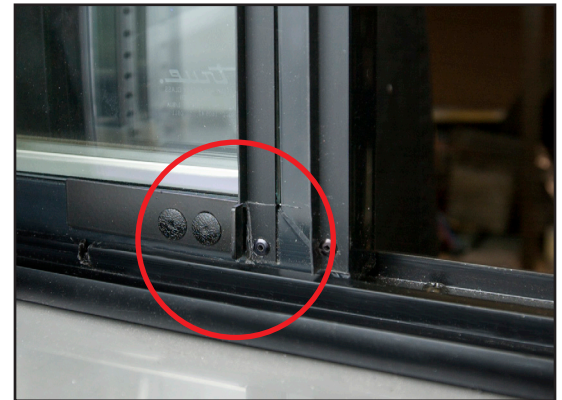
Fig. 2. El pestillo de la puerta está en la posición cerrada (desenganchado de la hendidura).
