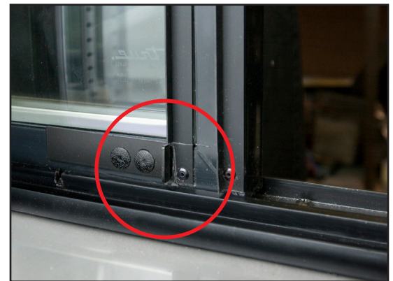
Image 2. Le verrou de porte est en position fermée (dégagé de l'encoche).
