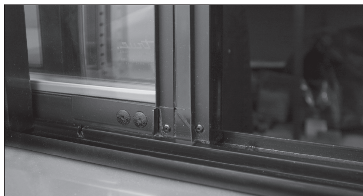
Fig. 2. Le verrou de la porte est en position fermée (désengagé de l'encoche).
