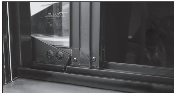
Fig. 1. El pestillo de la puerta está en posición abierta (encajado con la muesca).
