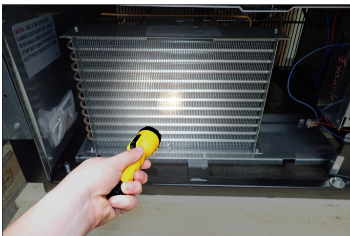
Rys. 3. Sprawdzić, czy wszystkie zatory zostały usunięte.
