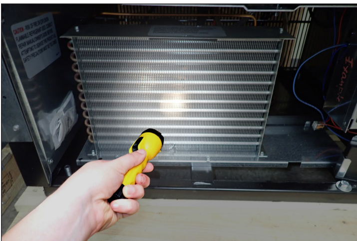
Fig. 3. Verificare che tutti i blocchi siano stati rimossi.
