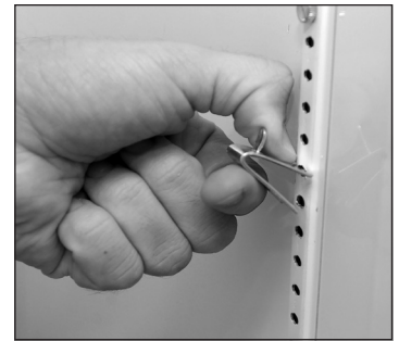
Fig. 2. La linguetta inferiore della clip per ripiani si fissa perfettamente.
