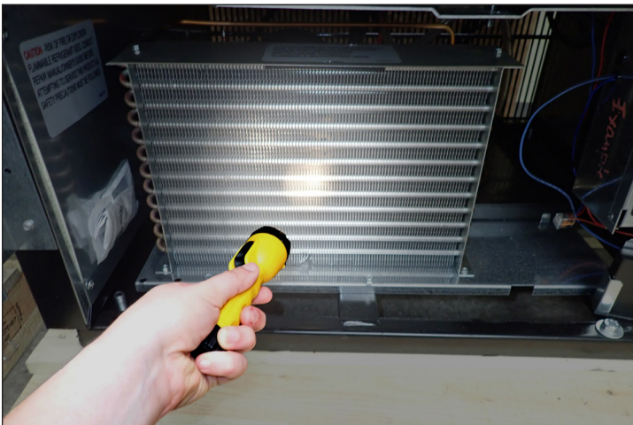
Abb. 3. Prüfen, ob alle Verstopfungen beseitigt wurden.
