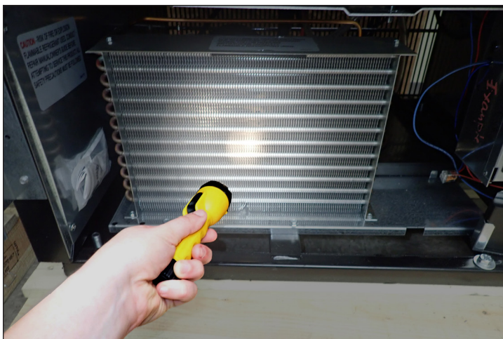
Afb. 3. Controleer of alle verstoppingen verwijderd zijn.
