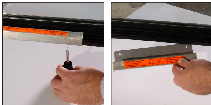
Rys. 2. Zdjęcie wspornika transportowego szklanych drzwi wahadłowych. Nie wyrzucać go.
