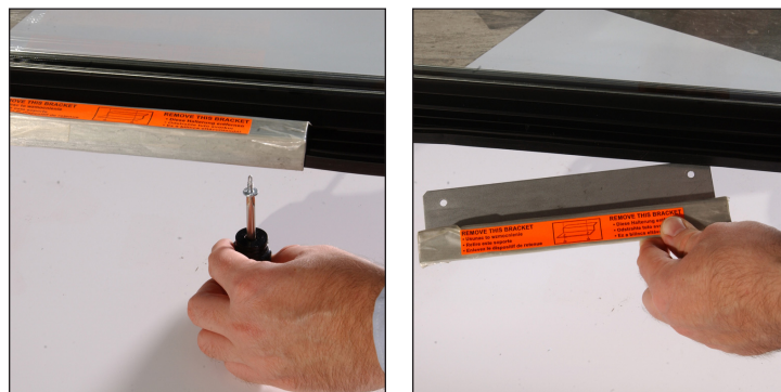
Abb. 2. Transportbügel der Glasschwingtür entfernen. Nicht wegwerfen
