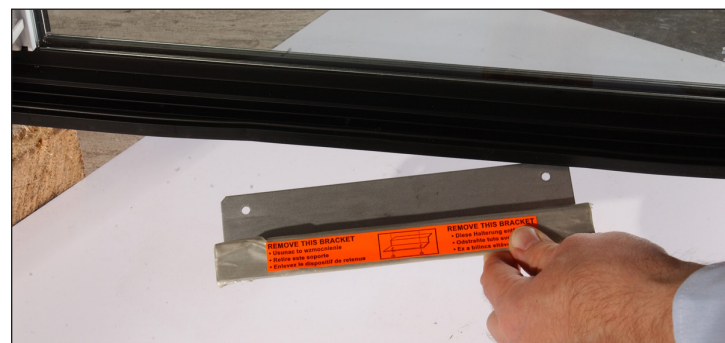
Rys. 2. Usunąć wspornik transportowy szklanych drzwi wahadłowych. Nie wyrzucać go.
