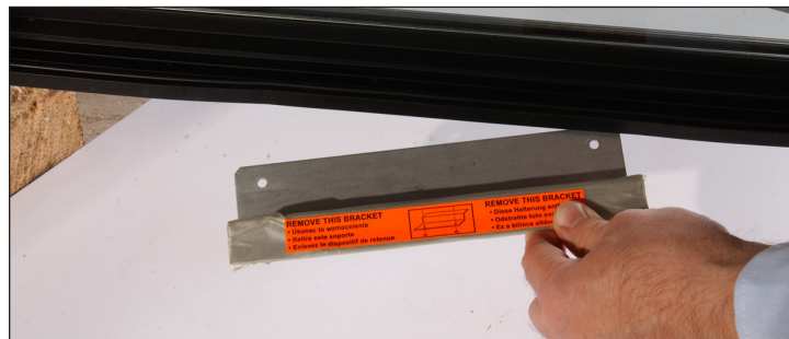
Abb. 2. Transportbügel der Glasschwingtür entfernen, falls vorhanden. Nicht wegwerfen
