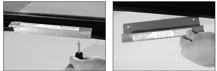
Fig. 2. Retire el soporte de transporte de la puerta batiente de vidrio, si se incluye. No deseche.
