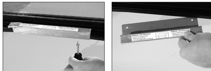
Fig. 2: Remova o suporte de transporte das portas pivotantes de vidro, se estiver instalado. Não descarte.
